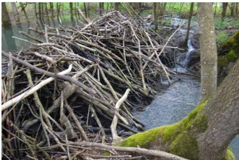
Biberdamm im Sindelbach – aufwärts für Fische unpassierbar, auch bei Hochwasser
