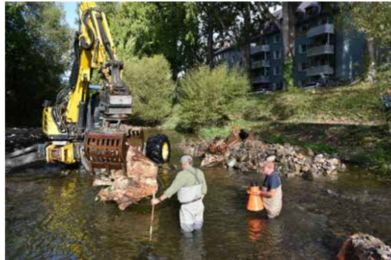
Bau eines Kältepools in der Dreisam in Freiburg
